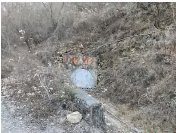
照片 1-13 1310 硐口封堵后（镜向 176°）
