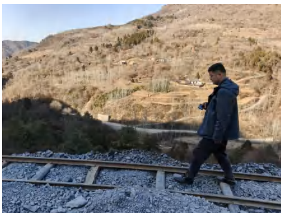
照片 3-3 现场实际调查
