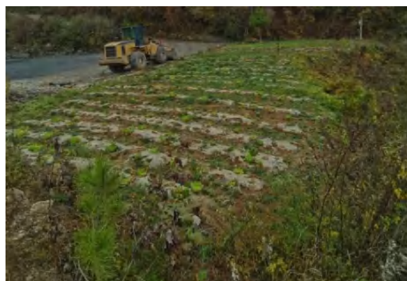
照片 1-7 1#渣堆治理后（镜向 166°）
