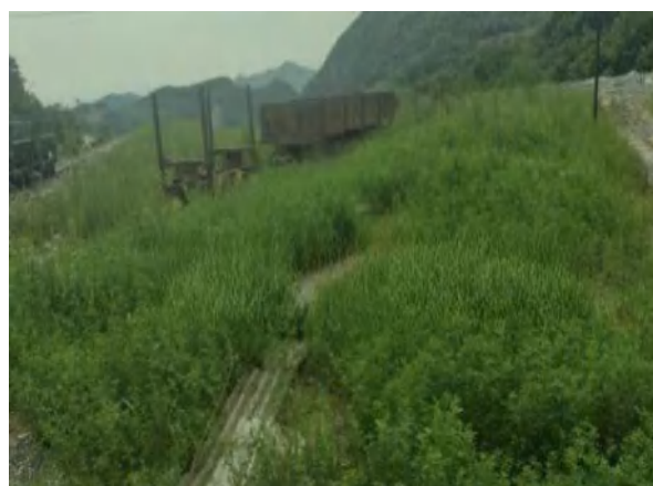
照片 1-9 2#渣堆治理后（镜向 303°）
