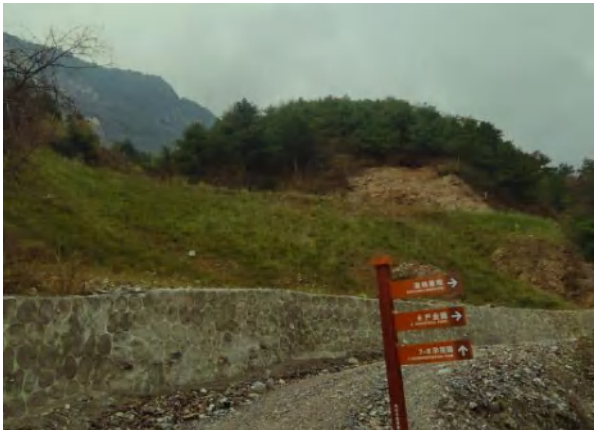
照片 1-11 4#渣堆治理后（镜向 57°）
