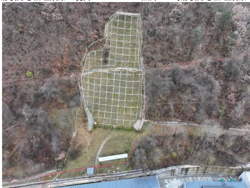
照片2-9 1490平硐口上方边坡治理效果（镜向173°）
