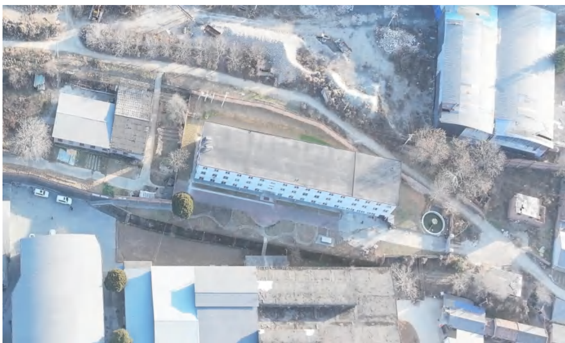
照片1-1 办公生活区现状（镜向179°）
