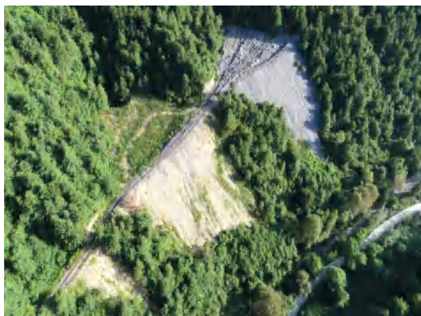
照片1-4 H2滑坡治理前（镜向203°）
