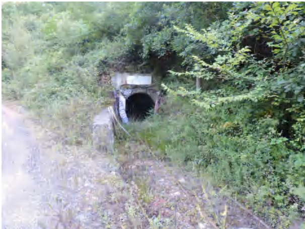
照片1-12 1310硐口封堵前（镜向174°）
