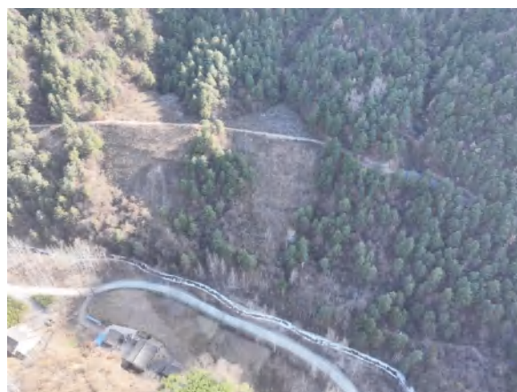
照片1-5 H2滑坡治理后（镜向1179°）
