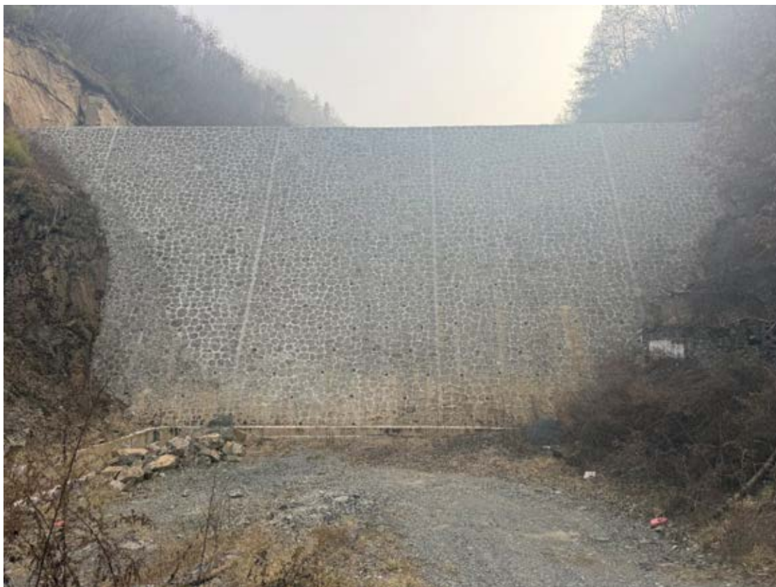
照片2-6 水晶沟区域 1500m 高程以上区域治理后封闭道路的拦渣坝（镜向 215°）
