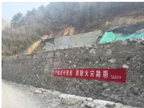
照片 2-7 临时转运场坡脚挡墙（镜向 135°）
