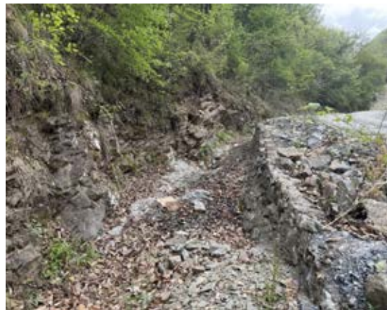
照片 3-11 临时排水渠（镜向 240°）
