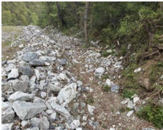
照片 3-10 临时排水渠（镜向 45°）
