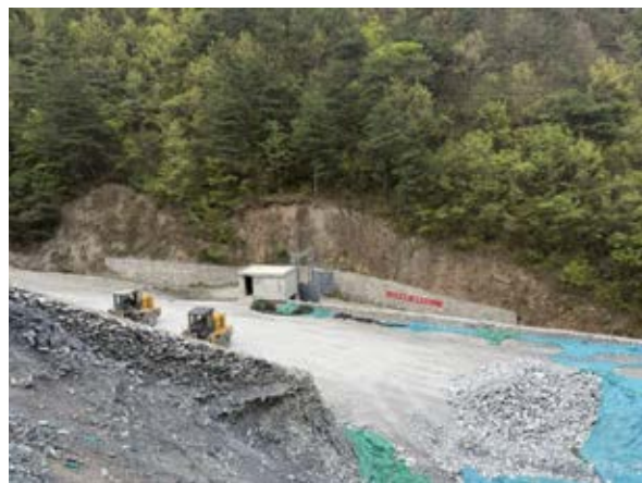
照片 3-2 临时转运场对面挡墙（镜向 350°）
