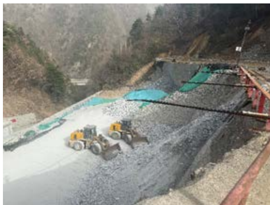
照片 1-8 临时转运场（镜向 80°）
