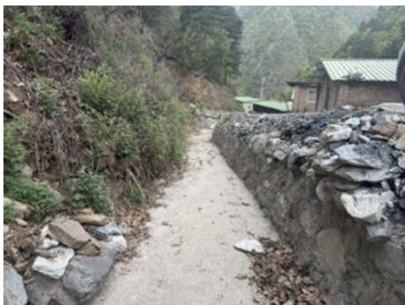
照片 3-3 场地排水沟（镜向 85°）
