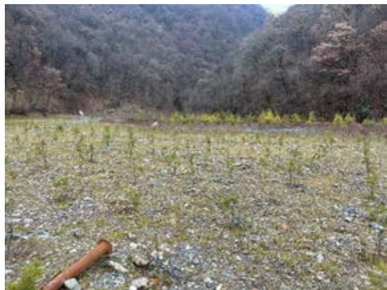
照片 2-13 废石场复垦工程效果
