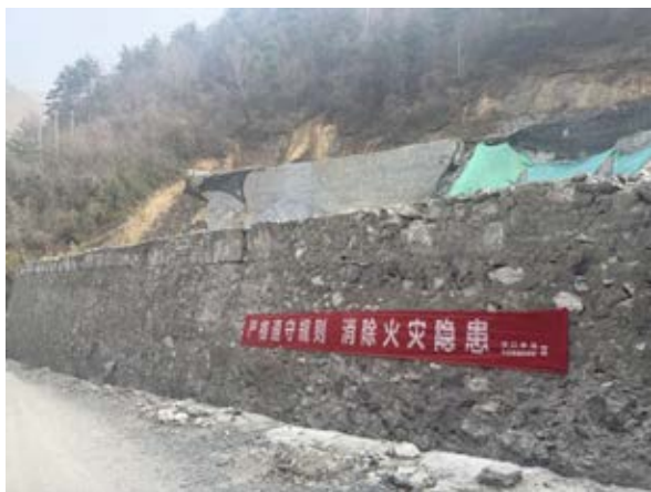
照片 3-1 临时转运场坡脚挡墙（镜向 165°）
