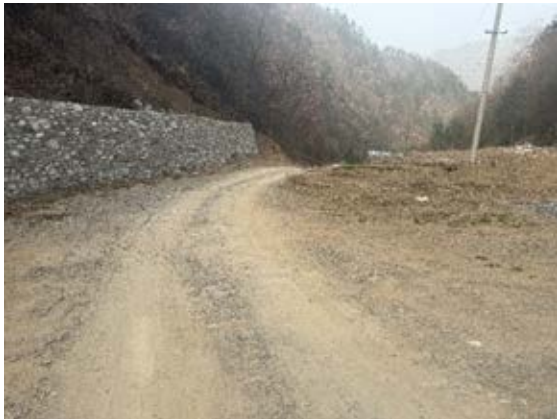
照片 1-15 运矿道路（镜向 85°）
