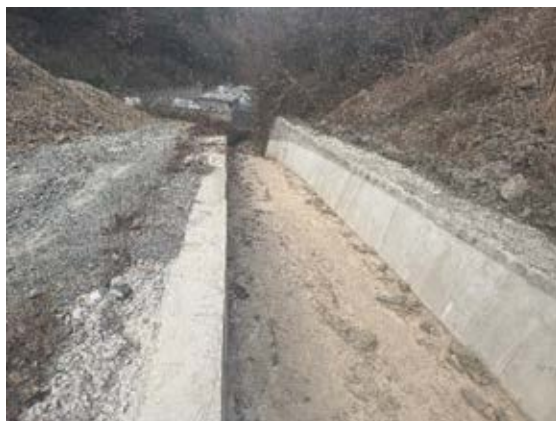
照片 2-8 混凝土排水渠（镜向 50°）
