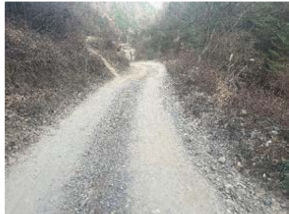
照片 1-16 运矿道路（镜向 50°）
