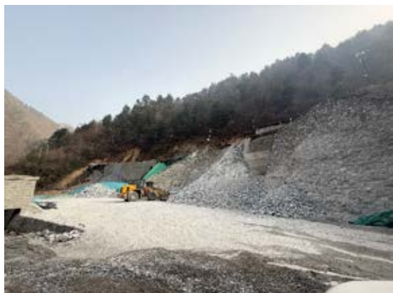
照片 1-7 临时转运场（镜向 135°）
