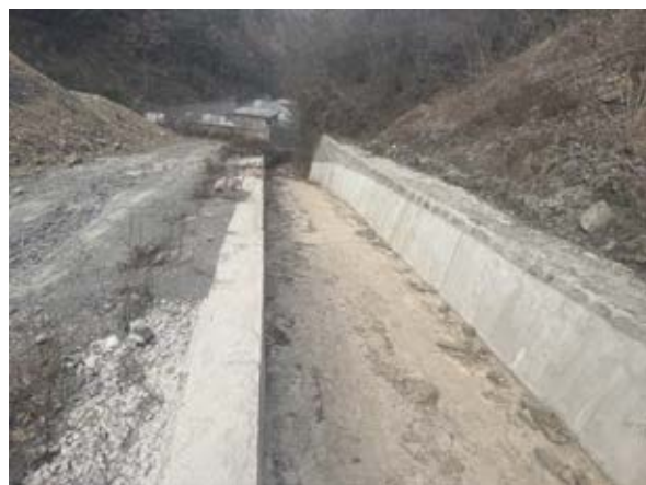
照片 3-4 FX02 坡脚排水沟（镜向 40°）
