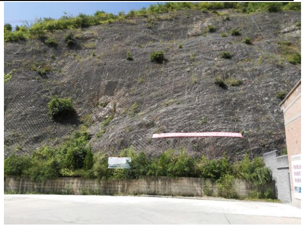
照片 2-24 治理后的滑坡(镜向 220°)
