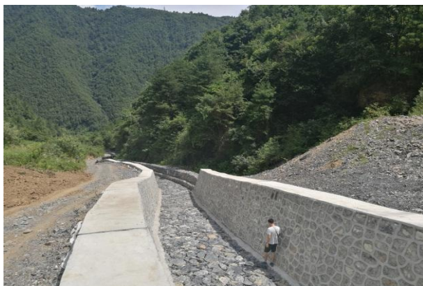
照片 2-17 拦渣墙及排洪渠(镜向 35°)
