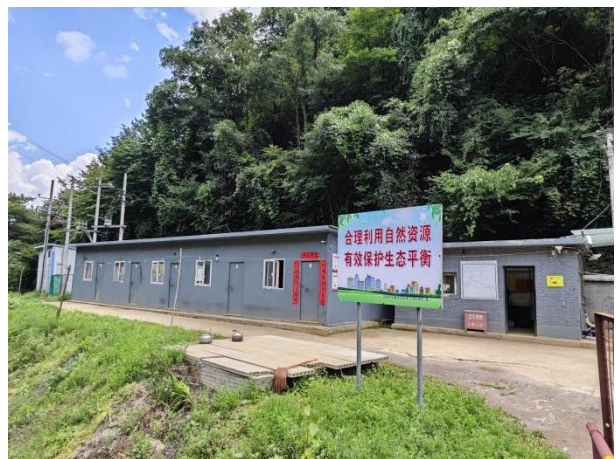
照片 1-3 值班房（镜向 150°）
