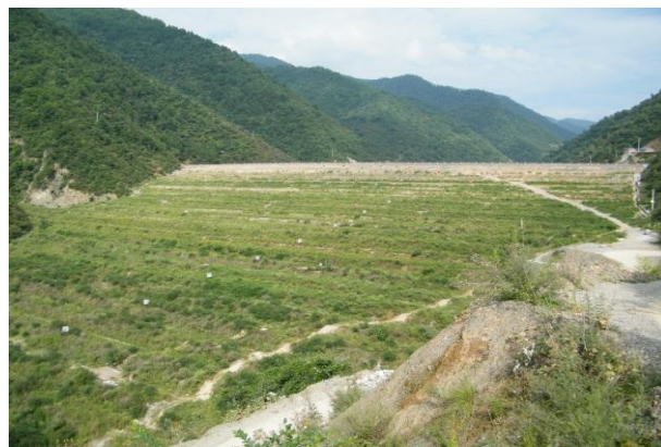
照片 2-18 森崖沟尾矿库治理(镜向 130°)
