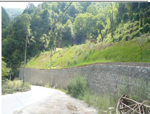
照片 2-20 渣堆治理效果(镜向 290°)
