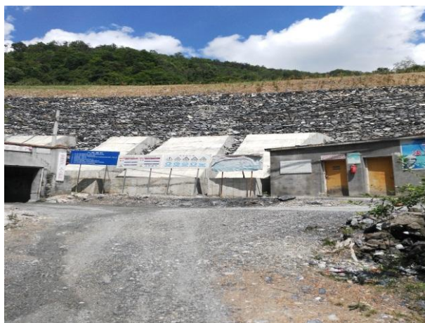
照片 2-22 渣堆挡墙(镜向 245°)
