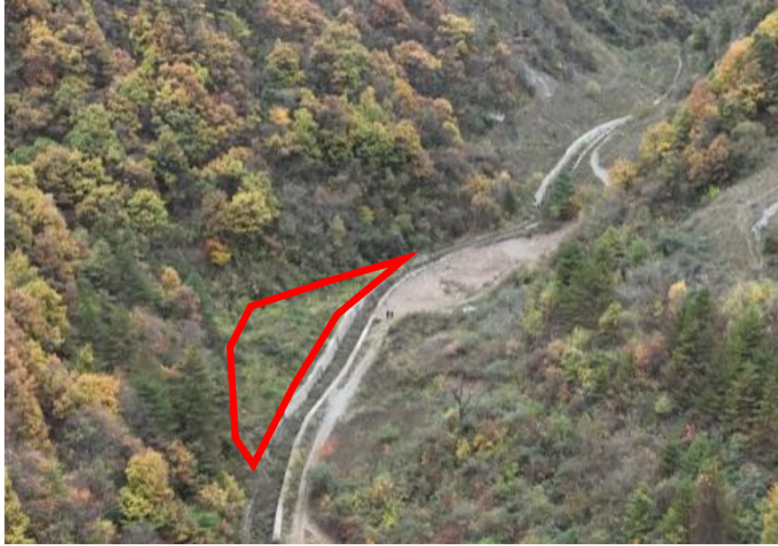
照片 1-9 Z1 渣堆（镜向 140°）
