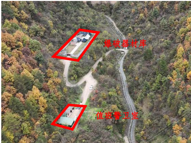
照片 1-7 爆破器材库（镜向 230°）
