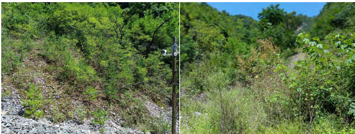
照片 2-13 ZD3、ZD5 复垦绿化工程
