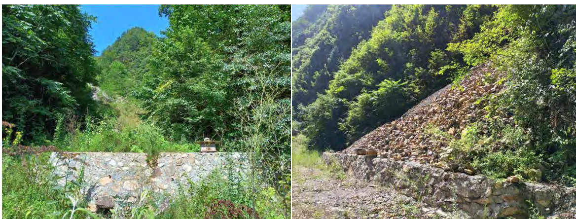
照片 2-8 废渣堆 ZD5、ZD6 拦挡墙工程
