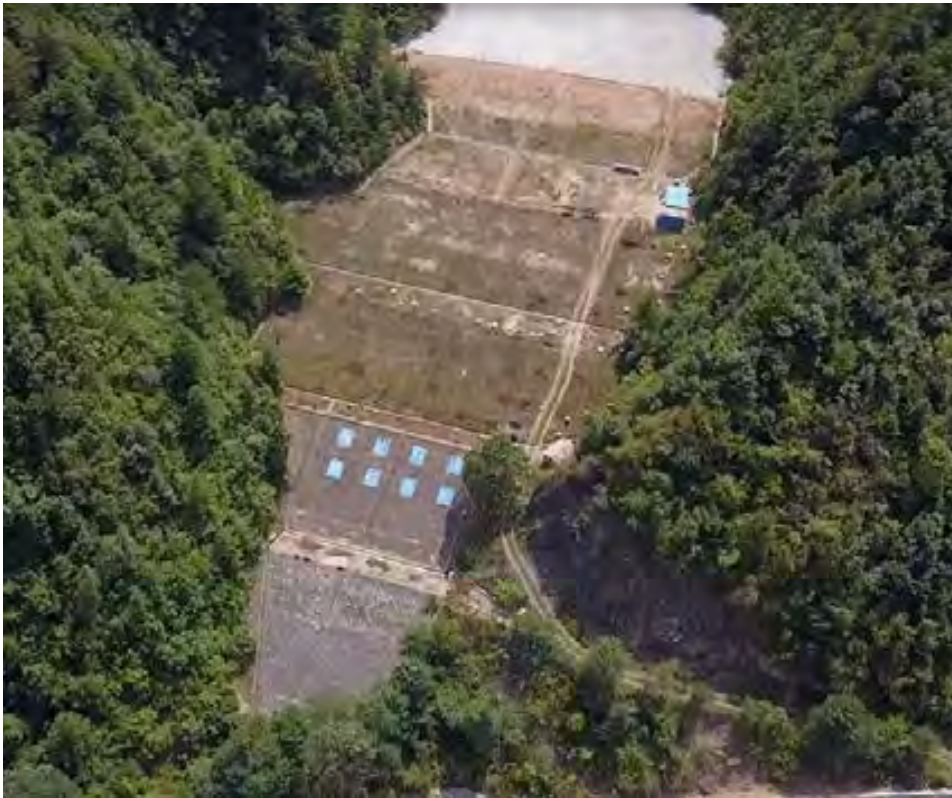
照片 1—2 凤县洞沟铅锌矿尾矿库坝体
