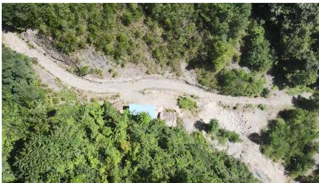
照片 1-5 ZD3 废渣堆照片
