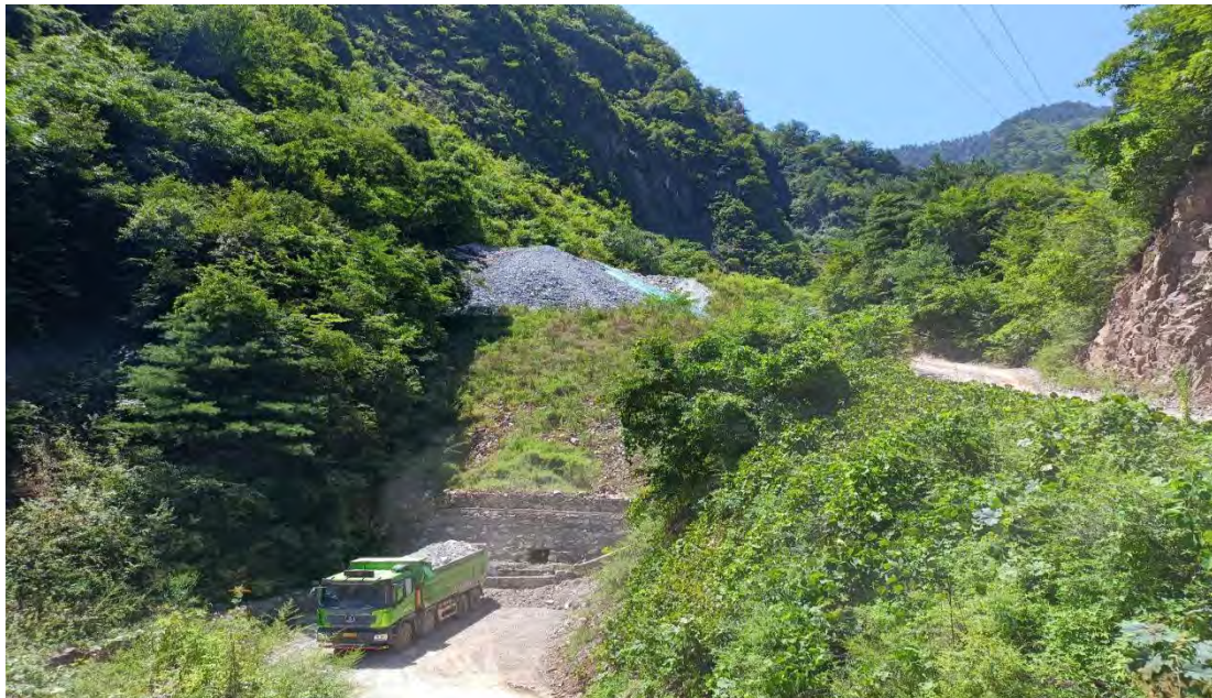
照片 1-11 ZD9 废渣堆照片
