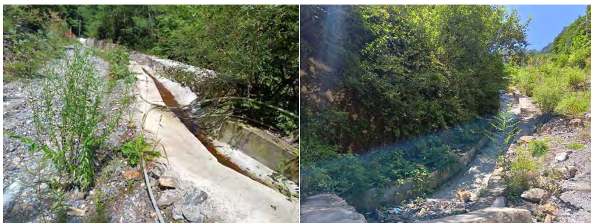
照片 2-10 废渣堆部分截排水工程
