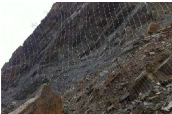
照片 2-15 不稳定边坡挂网防护效果
