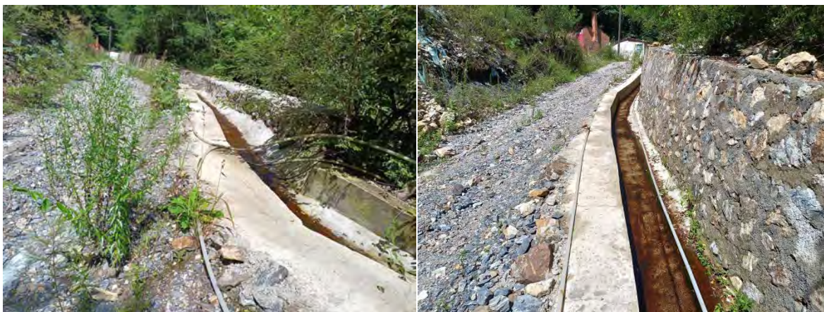
照片 2-6 废渣堆外侧截排水工程
