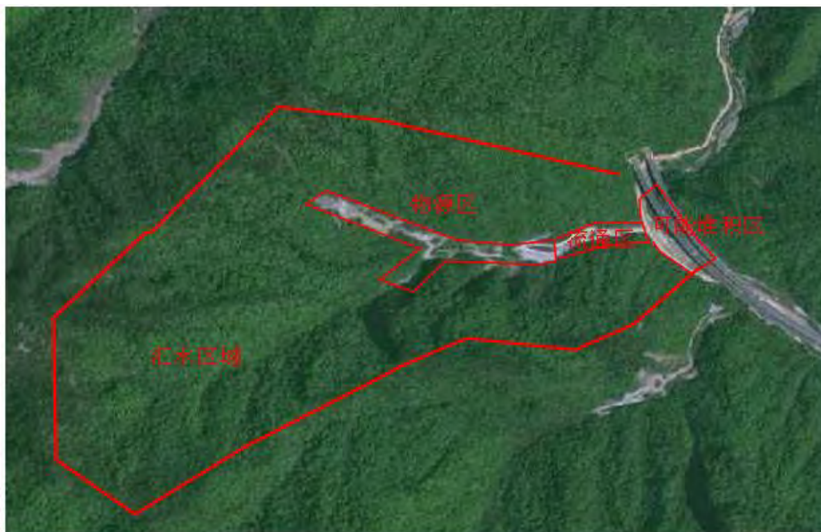
照片3-6 洞沟泥石流评估
