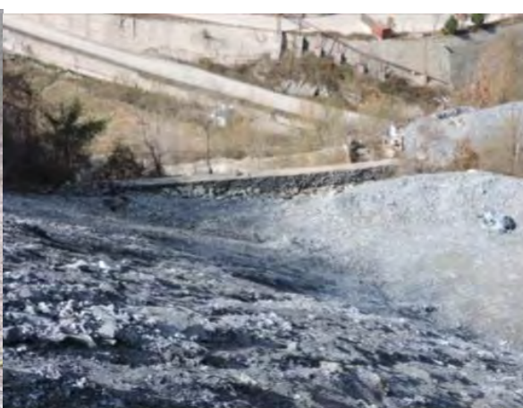
照片 2-18 渣堆坡脚拦渣墙防护效果
