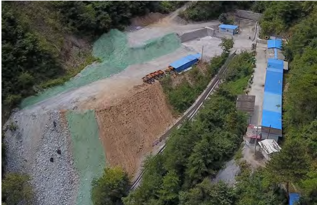
照片 1-12 办公生活区及 1281m 平硐口工业场地(镜像 275°)
