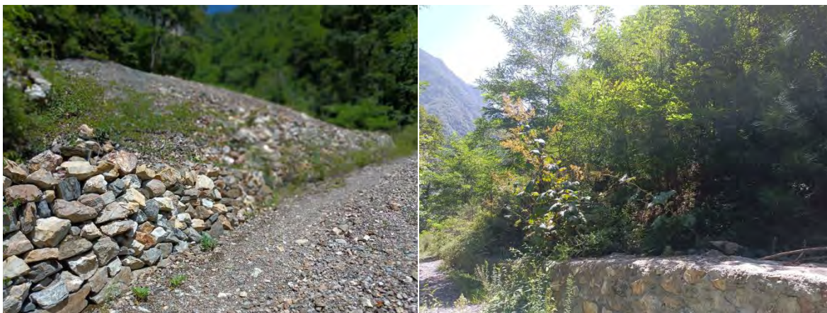
照片 2-7 废渣堆 ZD2、ZD3 拦挡墙工程
