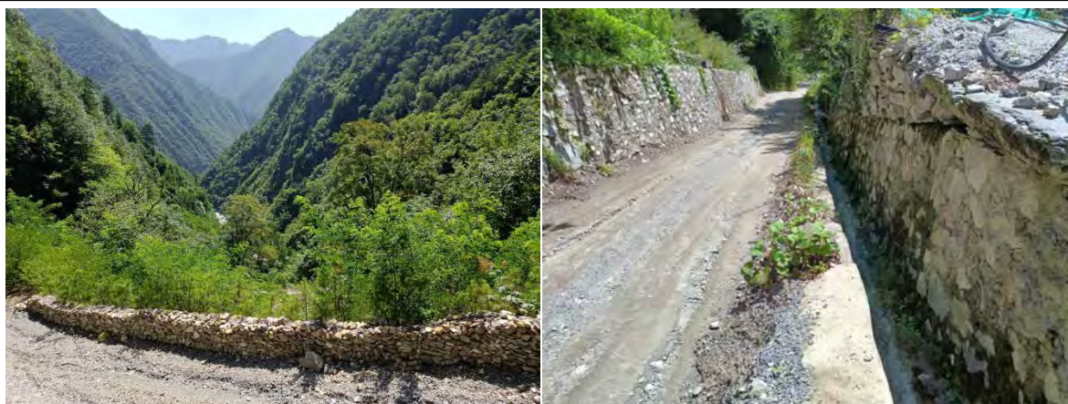
照片 2-5 废渣堆底部拦挡墙工程
