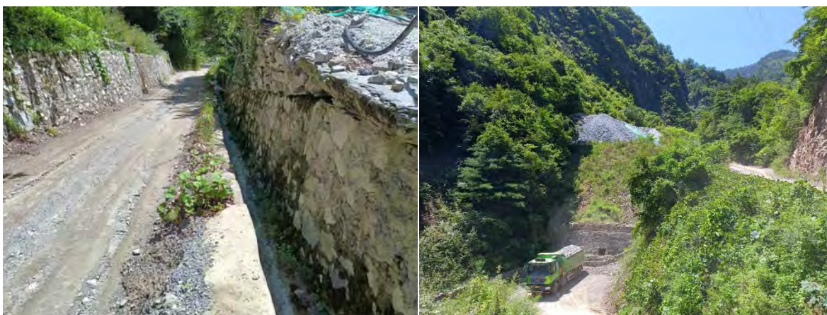
照片 2-9 废渣堆 ZD7、ZD9 拦挡墙工程
